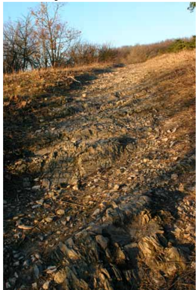
Durch Wanderer verursachte Erosion: Steige
